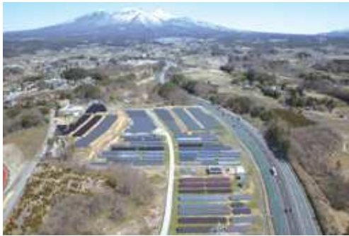
図1.大規模太陽光発電所の例(山梨県北杜市) 画像提供: 新エネルギー・産業技術総合開発機構(NEDO)
